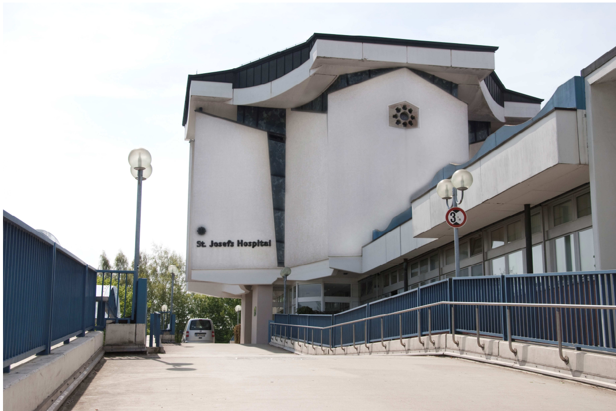
Abbildung: Haupteingang St. Josefs-Hospital
